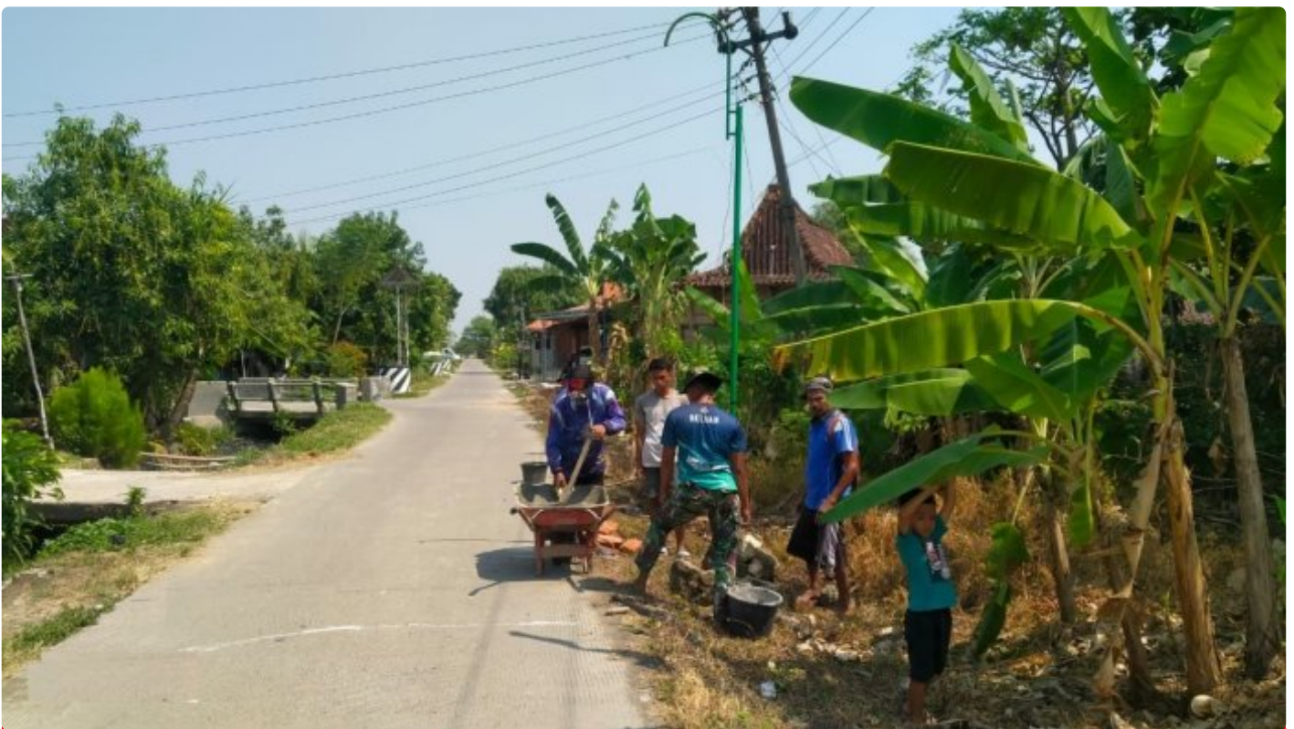
Satgas TMMD Reguler Ke-117 Kodim 0717/Grobogan Perbaiki Tiang Lampu Penerangan Jalan Di Desa Cangkring
