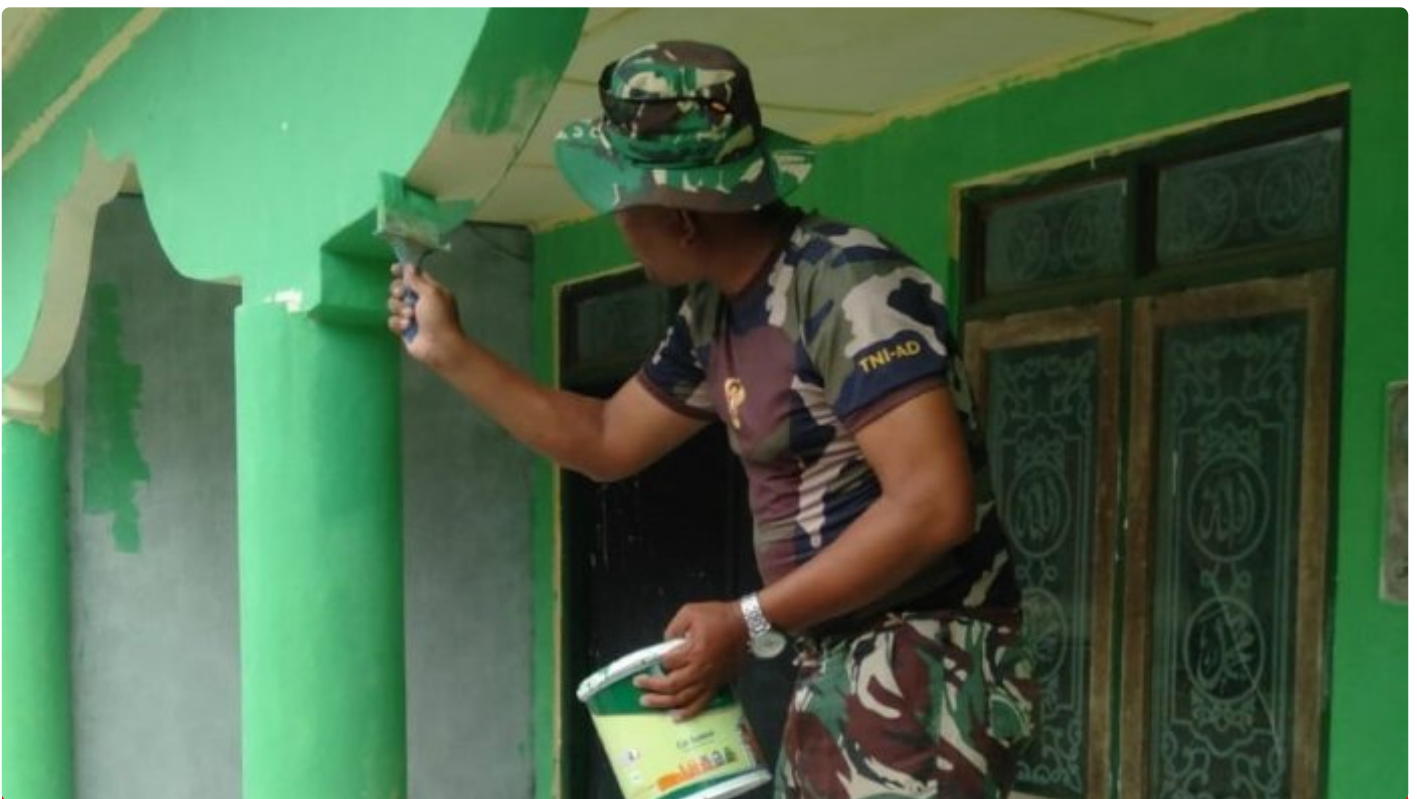
Satgas TMMD Lakukan Pengecatan Finishing Rehab Mushola Di Desa Cangkring
