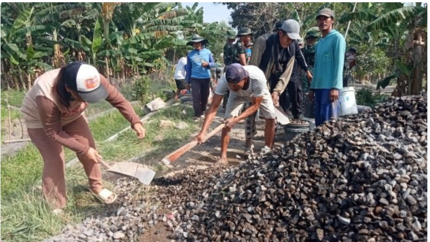
Antusias Warga Cangkring Dalam Pengeroran Jalan Sasaran TMMD
