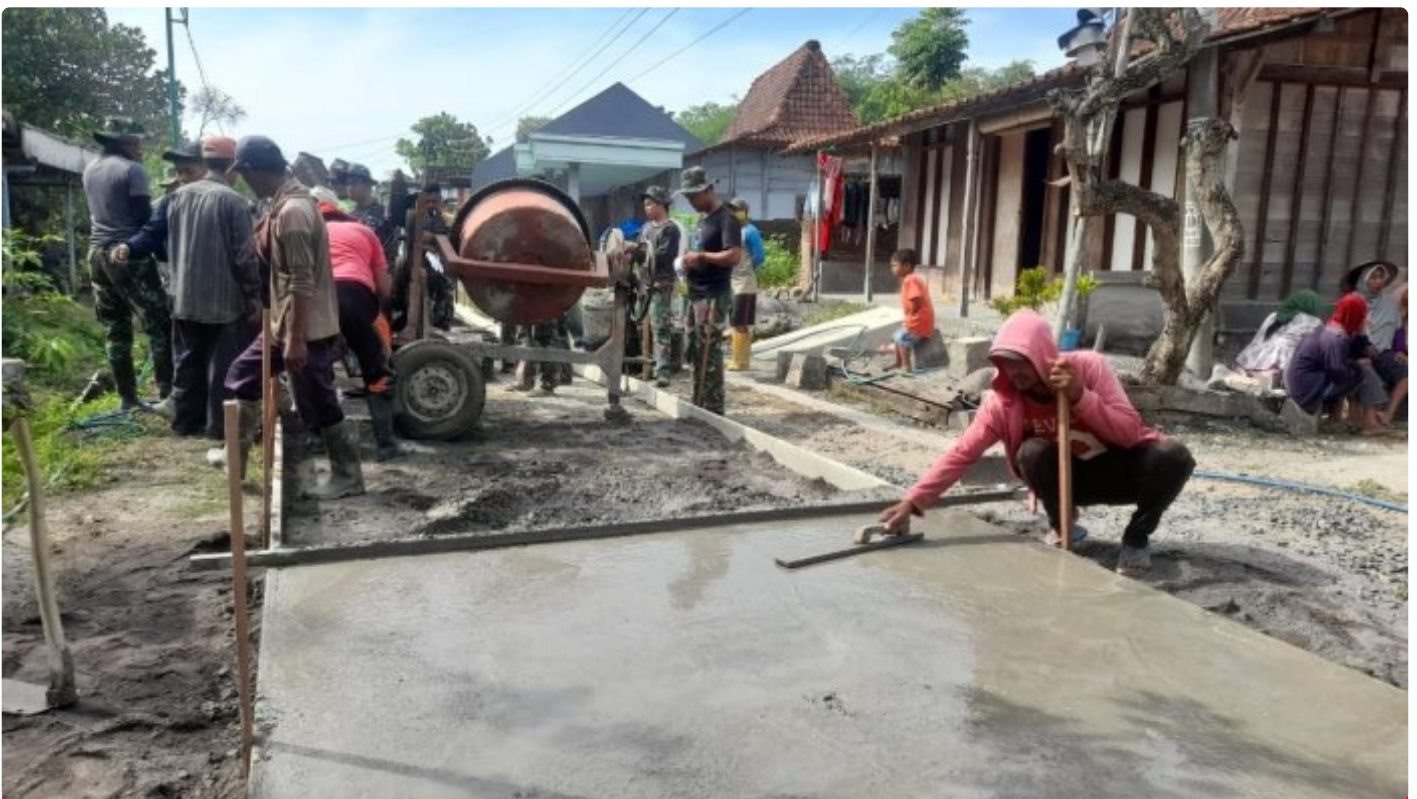
Proses Pengecoran Jalan Program TMMD Reg Ke-117 Di Desa Cangkring
