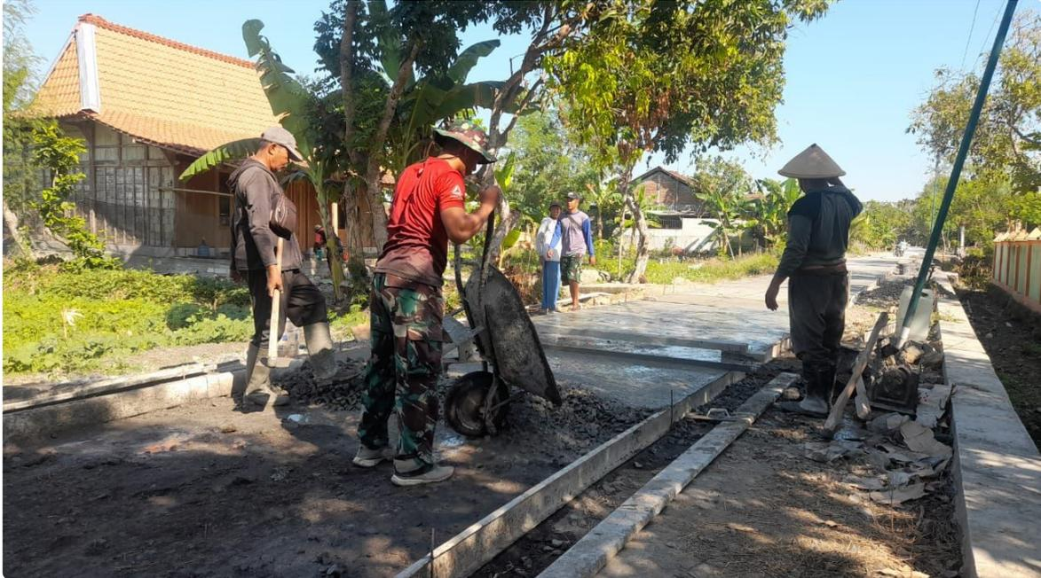
Menurut Danki Satgas TMMMD Lettu Inf M. Nur Rosidi, peningkatan jalan dengan cor beton (rabat beton) sepanjang 750 meter, lebar 2,5 meter dan tebal 15 centimeter kini menginjak separuh waktu pelaksanaan, untuk pembangunan jalan yang menjadi salah satu sasaran fisik TMMMD di Desa Cangkring itu sudah mencapai 85 persen.
